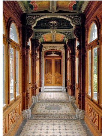
1: Galerie mit Mettlacher Mosaikplatten (Bild SHS)
