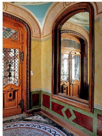
3: Vorhalle mit marmorierten Wandflächen (Bild PST)
