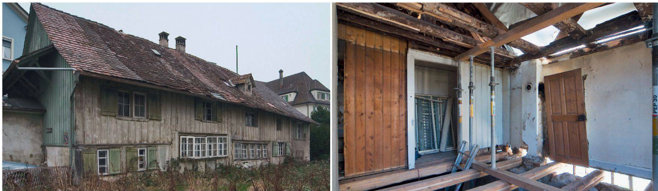
Die Fischerhäuser in Romanshorn waren lange vom Abbruch bedroht. Zurzeit werden sie von der Denkmal Stiftung Thurgau instand gestellt. (Bilder Lukas Fleischer)
