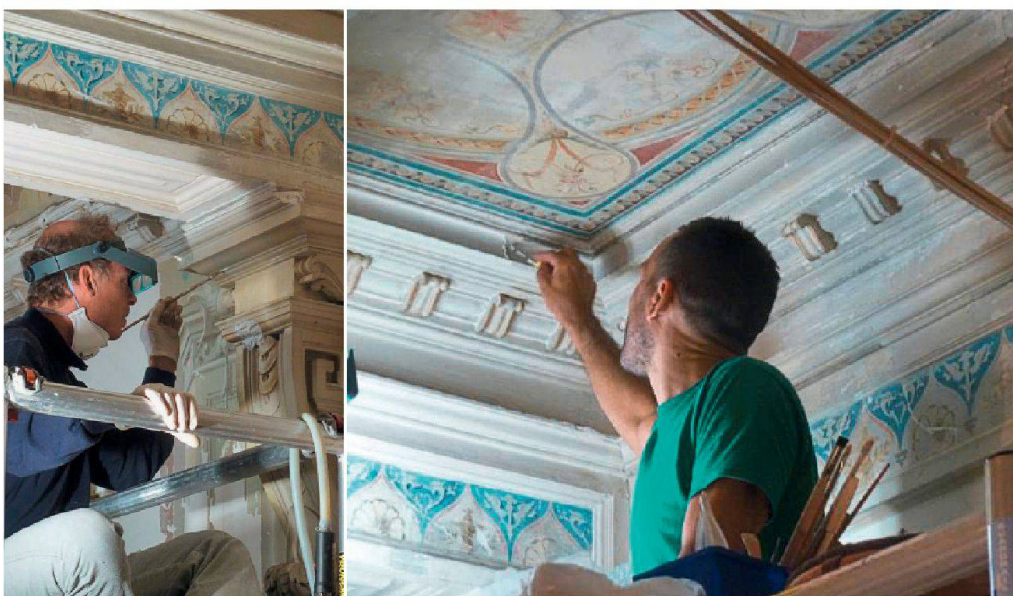
Gewisse Partien im Innern der Villa Patumbah sind bis zu sechs Mal übermalt.
