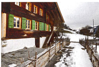
Haus auf der Kreuzgasse Boltigen, 2011
