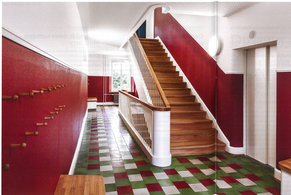
Die neu gebaute Treppe im 2013 umgebauten Schulhaus Wettingerstobel in Zürich (ARGE Joos & Mathys mit Imhof Nuffeler). Die eingesetzten Materialien und Techniken gab es schon bei der Erweiterung und Umgestaltung des Gebäudes zum Schulhaus (1854). Le nouvel escalier de l'école zurichoise de Wettingerstobel rénovée en 2013 (ARGE Joos & Mathys en collaboration avec Imhof Nuffeler). Les techniques et matériaux utilisés existaient déjà lors de l'extension et de la transformation du bâtiment en école (1854).
