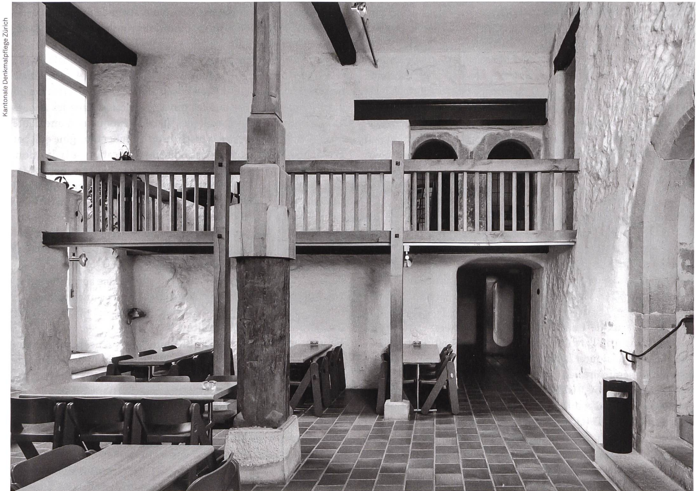
Vorher: die Doppelstütze im Foyer zur Kapelle der Zürcher Helferei nach dem Umbau von Manuel Pauli (Aufnahme von 1978)
