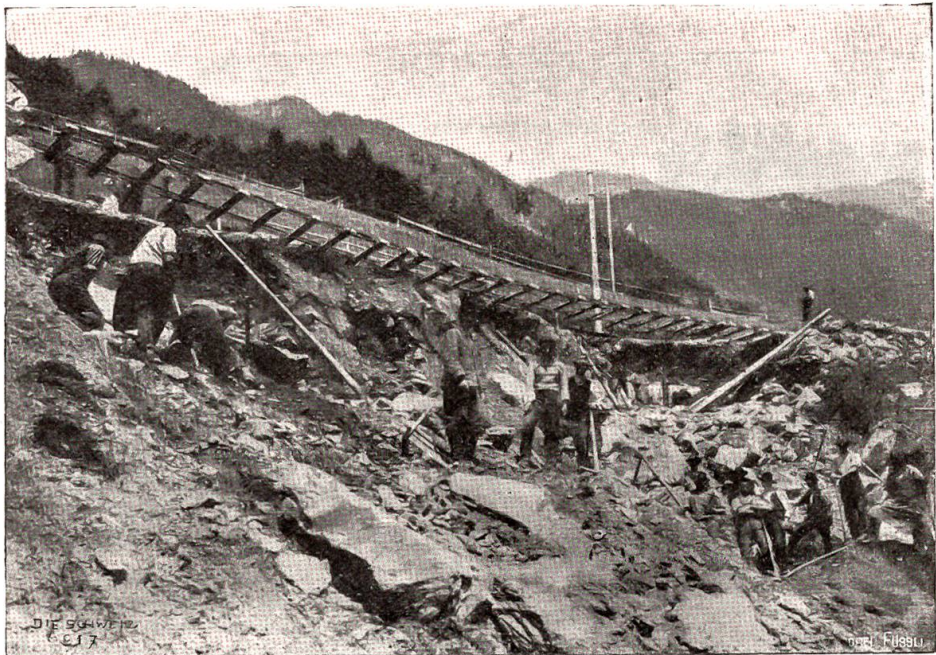
Sernstalstraße u. Bahnlinie durch Hochwasser zerstört. Phot. Schönwetter-Umer, Glarus.
