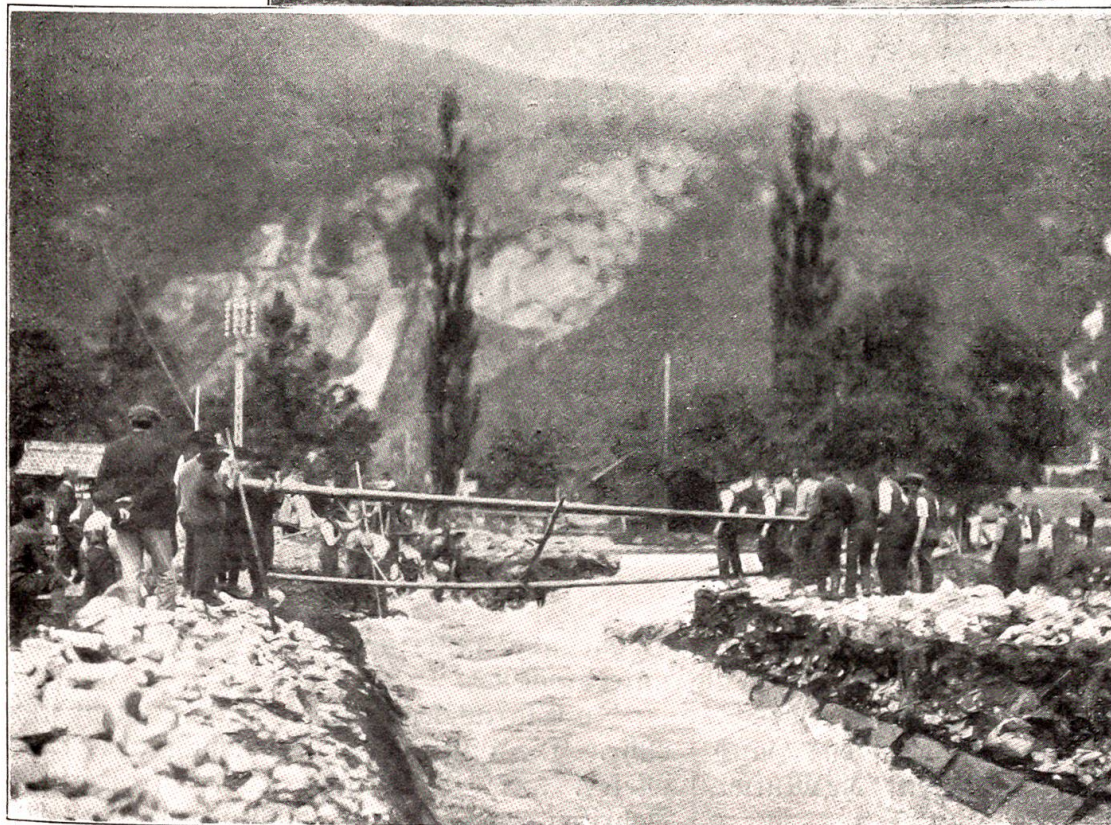
Oberhasli. Befestigen des Wehrens zum Zurückhalten des Geschiebes. Phot. A. Brügger, Weiringen.
