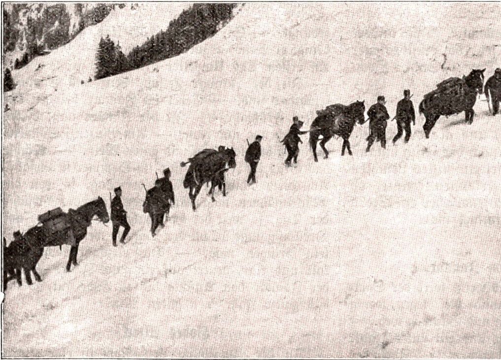
Aufstieg über unwegames Gelände.
