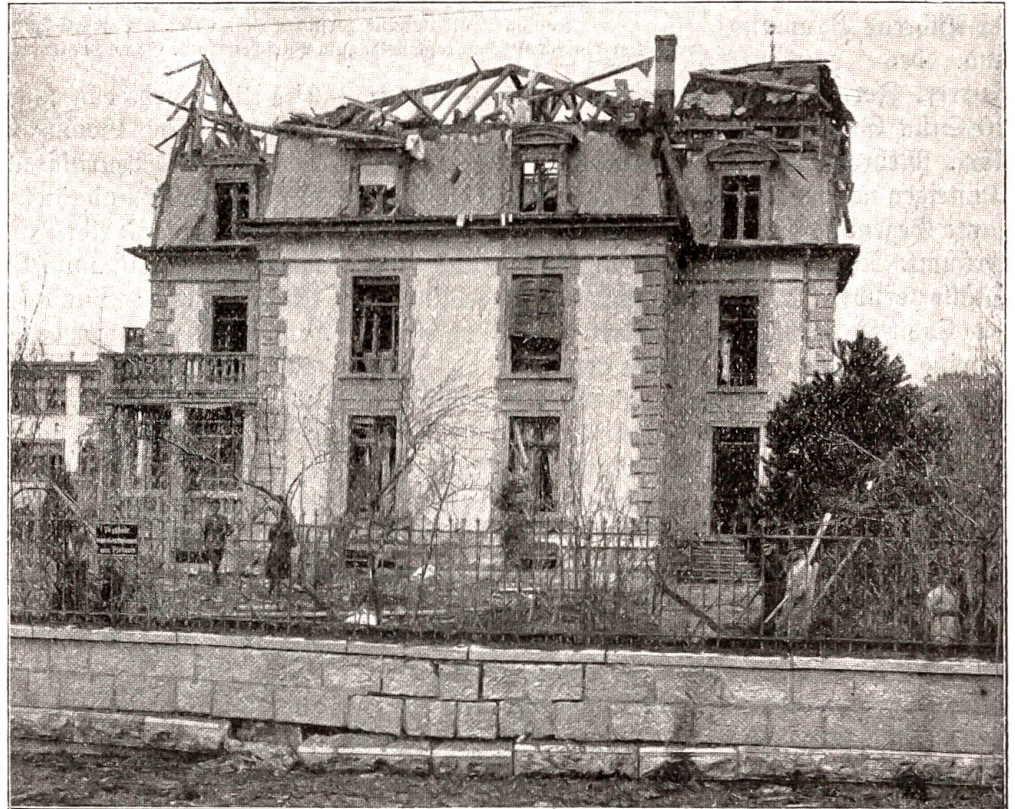
Vorderansicht des Hauses Theurillat in Bruntrut, welches durch eine Fliegerbombe zerstört wurde.
