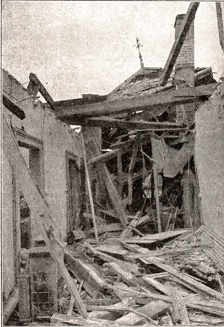
Der Vorraum des Dachlogis des Hauses Theurillat.
