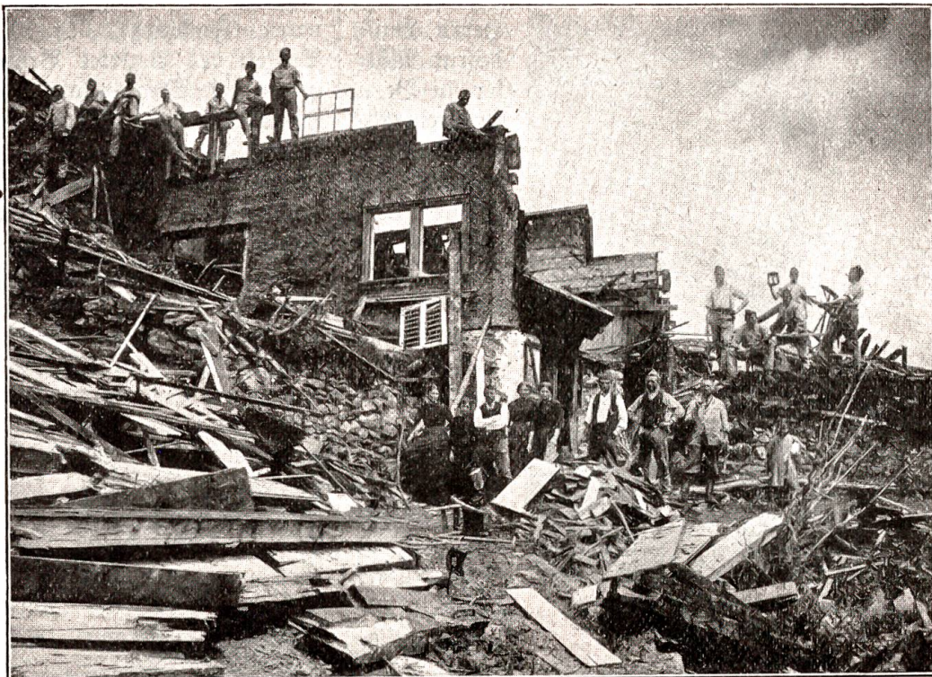
Das durch die Lawine zerstörte Schwimmwesen des Herrn Furger, auf Gurtneckerberg, welches erst durch die Schneeschmelze zum Vorschein kam. Es wurde unter Beihilfe des Bat. 87 abgebrochen.
