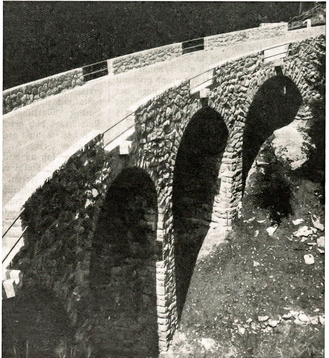
Bau der Sustenstrasse.
