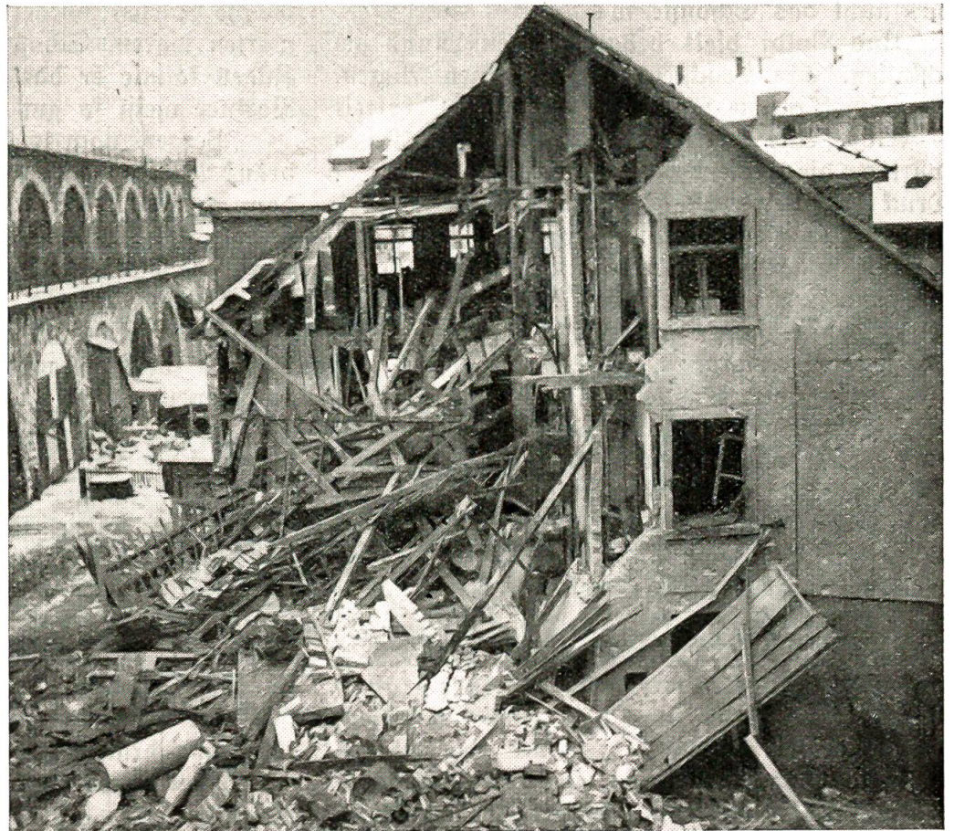
Bombenabwürfe in Zürich. Ein Hinterhaus an der Josefstraße wurde durch eine Bombe schwer beschädigt. J. Nr. VI Br. 6618. — Photopreß, Zürich.
