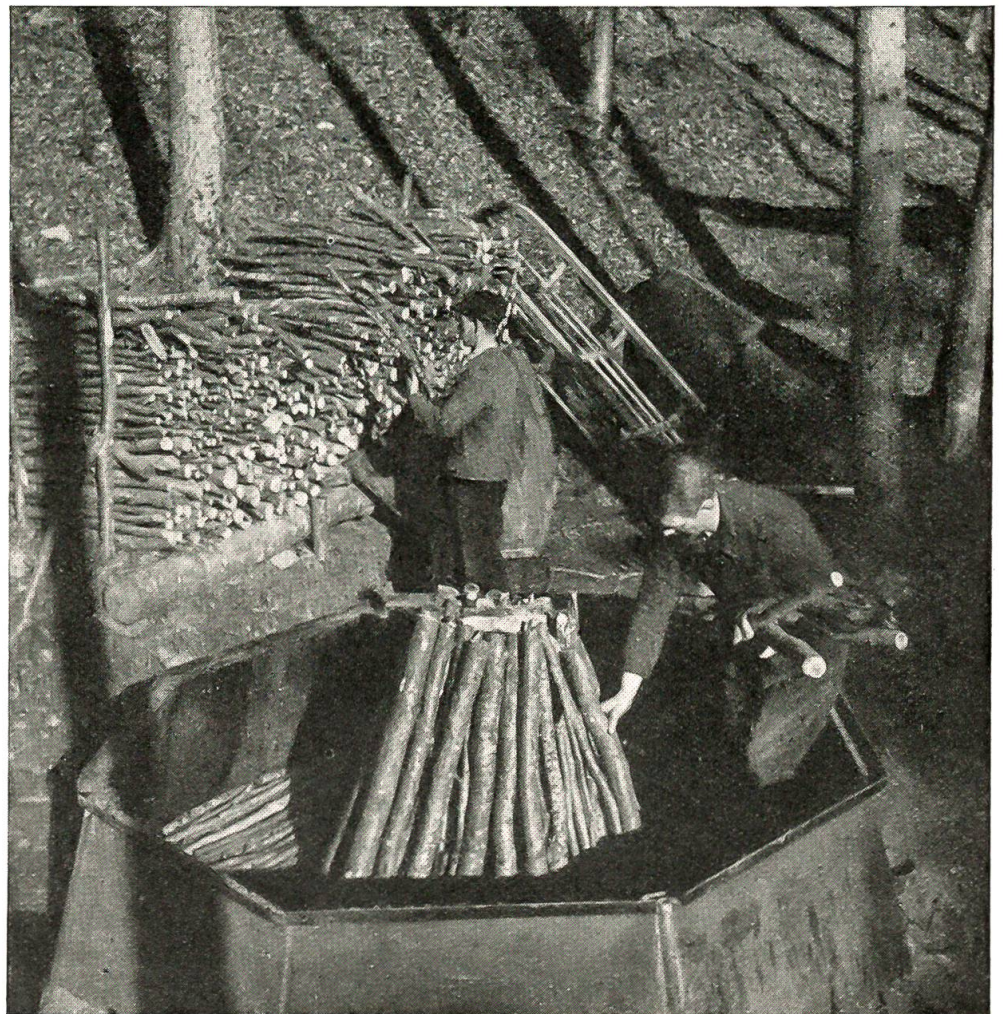
Der Aufbau des Holzes im Köhlerofen erfordert große Sorgfalt und viel Erfahrung. Das ist die Sache des Berufsköhlers, der zuerst eine Art von Rauchzug baut und dann das Rundholz darum herum legt.
