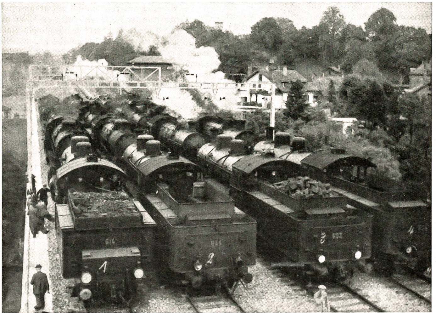
Belastungsprobe der viergleisigen Eisenbahnbrücke in Bern mit 20 Dampflokotiven im Gesamtgewicht von 2000 Tonnen.
