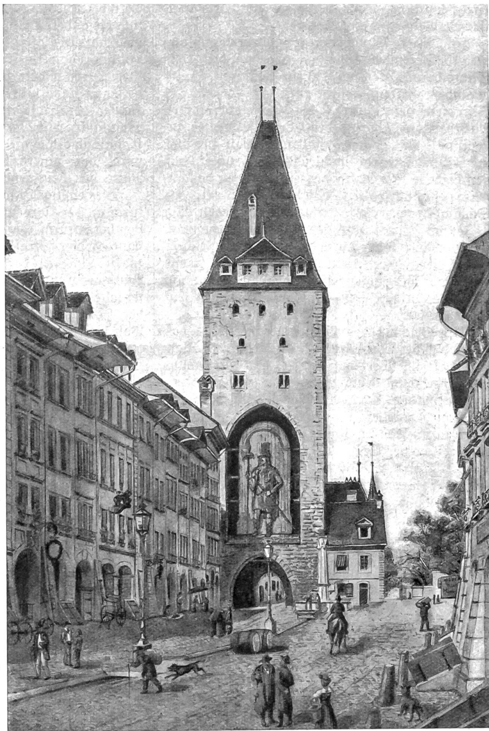
Der Christoffelturm von der Spitalgasse aus gesehen, kurz vor dem Abbruch im Jahre 1864
