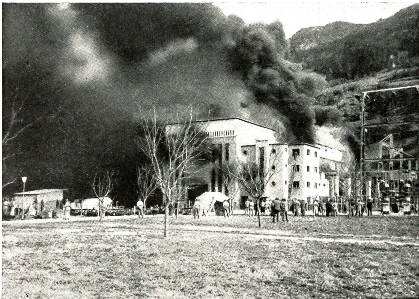
Großbrand im Kraftwerk von Chandoline, Wallis
