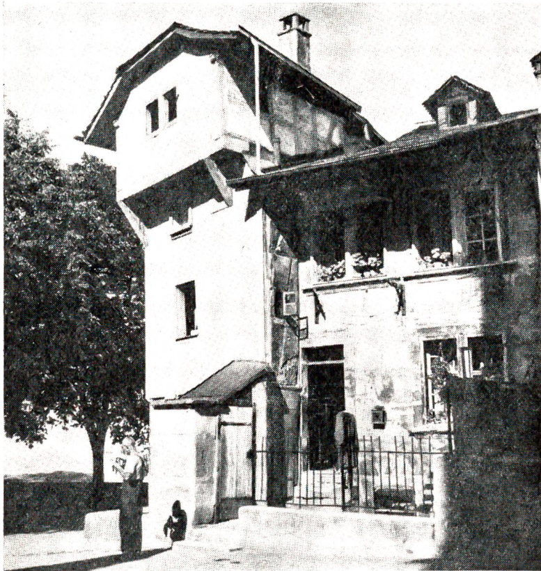
Wieder muß ein romantischer Winkel im Rindegghöfli in Bern der Altstadt-sanierung weichen.
