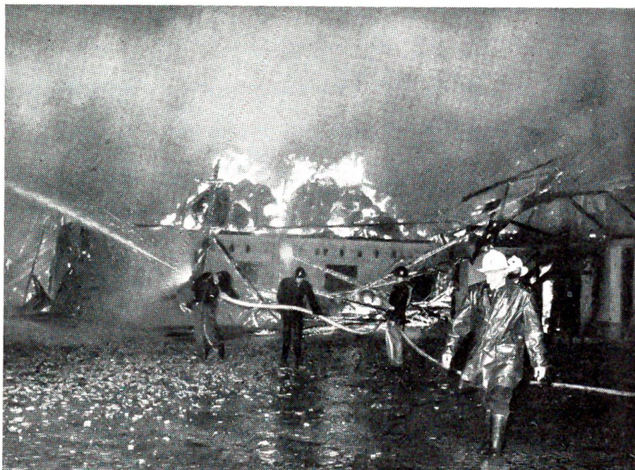
Ein Ökonomiegebäude des Fürsorgeheims der Stadt Bern in Kühlewil fiel einem Brandstifter zum Opfer Photo W. Nydegger, Bern
