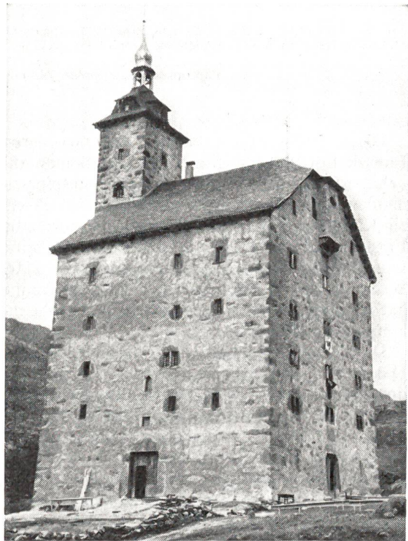
Das alte Simplon-Hospiz, in dem früher bedürftige Passgänger kostenlos Unterkunft und Verpflegung fanden, ist renoviert worden.
