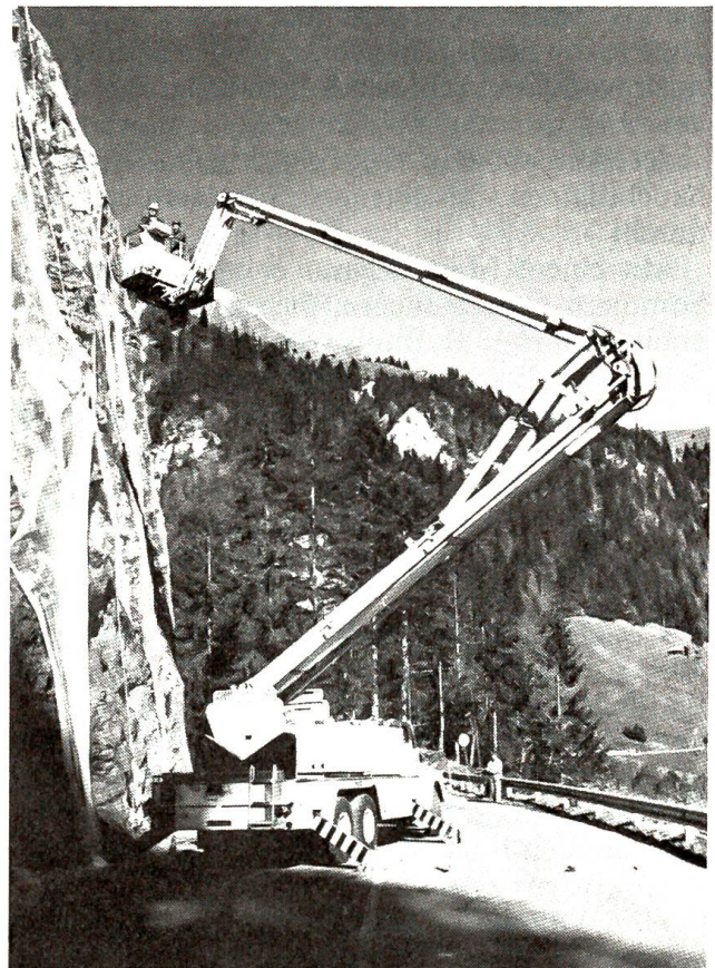
Eine Riesen-Hebebühne im Einsatz
