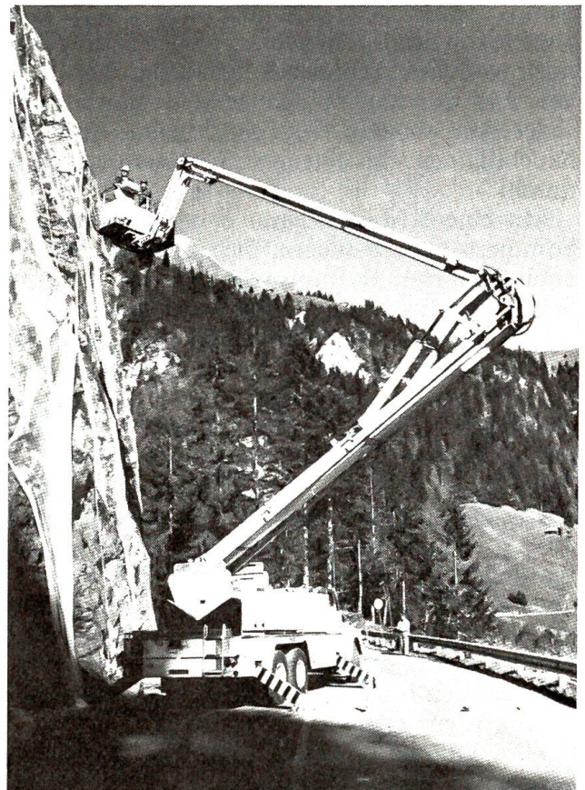
Eine Riesen-Hebebühne im Einsatz
