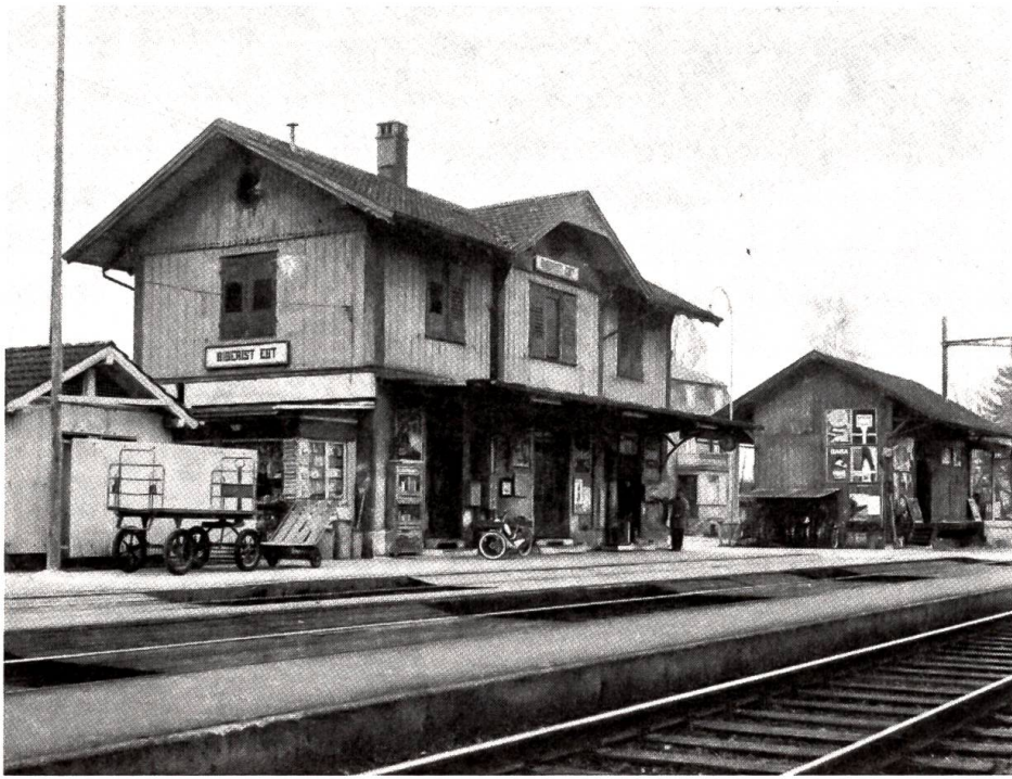
Altes Stationsgebäude Biberist, das einem modernen Neubau, welcher im Juni 1975 bezugsbereit war, weichen durfte. Photo Emmental-Burgdorf-Thun-Bahn, Werbedienst, Burgdorf.
