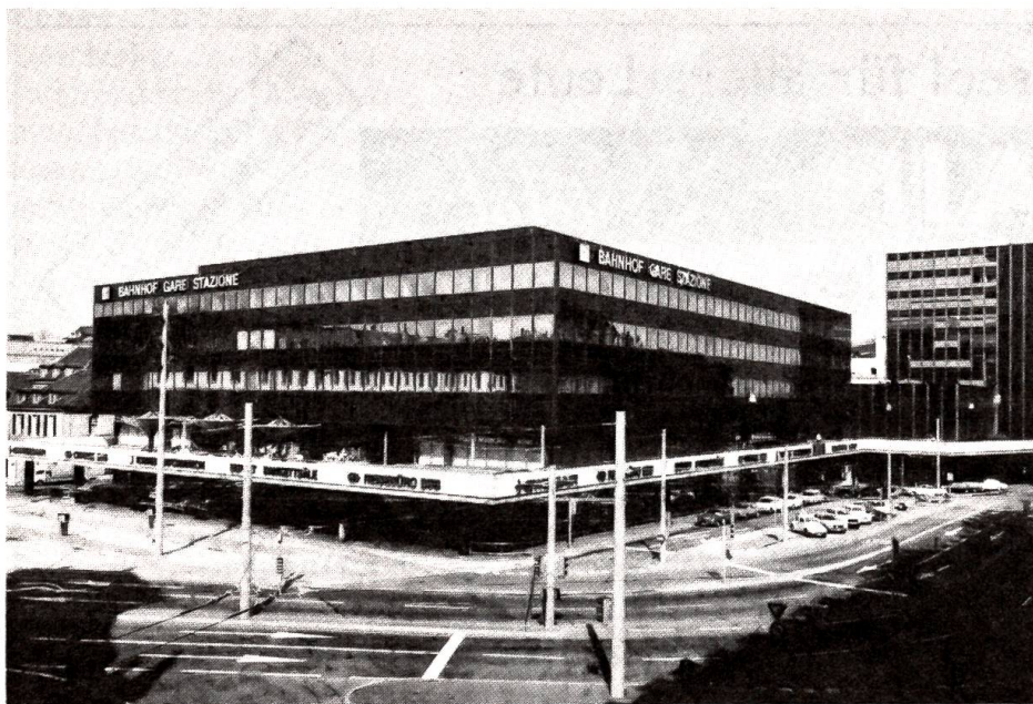
Der neue Bahnhof Bern, Gesamtansicht
