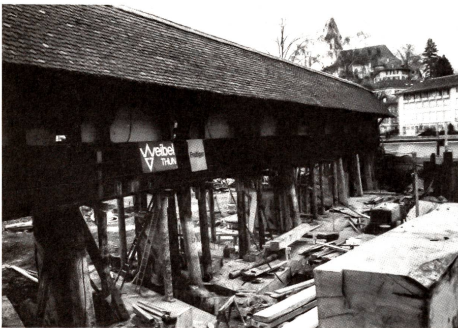
Die Scherzligenschleuse in Thun wird saniert
