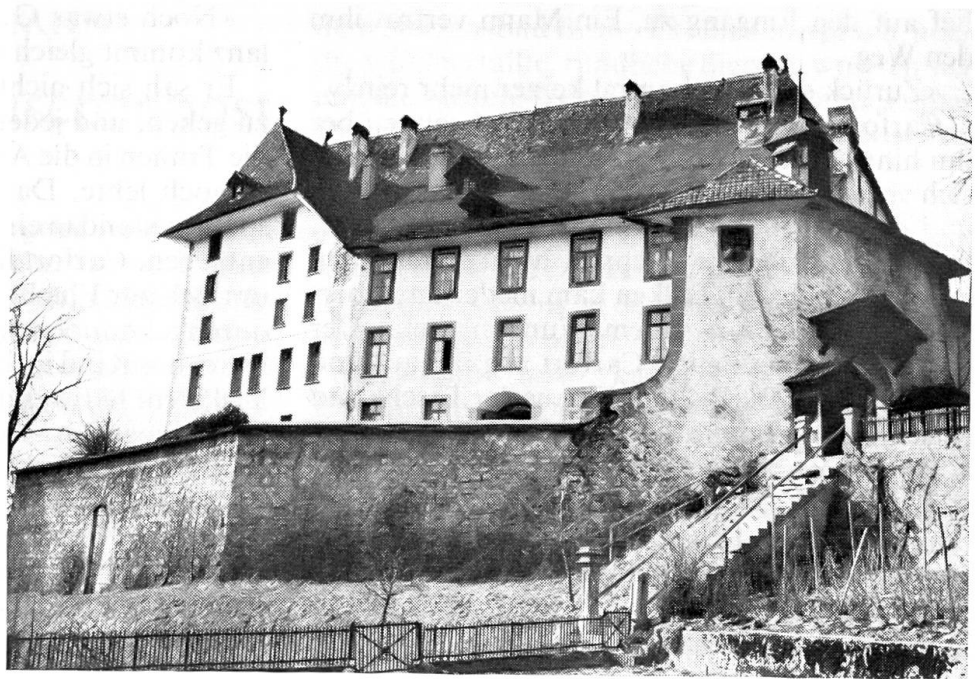
Schloss Sumiswald unter Denkmalschutz Diese ehemalige Landvogtei beherbergt heute ein Pflegeheim für Betagte. Photo Fritz Lörtscher, Bern
