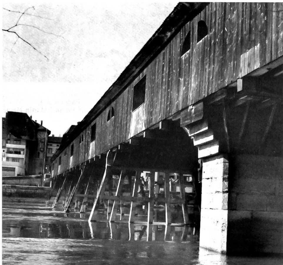
Die Holzbrücke in Büren a. d. A. Aufnahme aus dem Jahre 1967, Kunstdenkmäler des Kantons Bern, Photo † Martin Hesse
