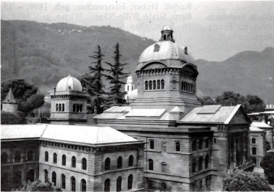
Das Bundeshaus versetzt?
