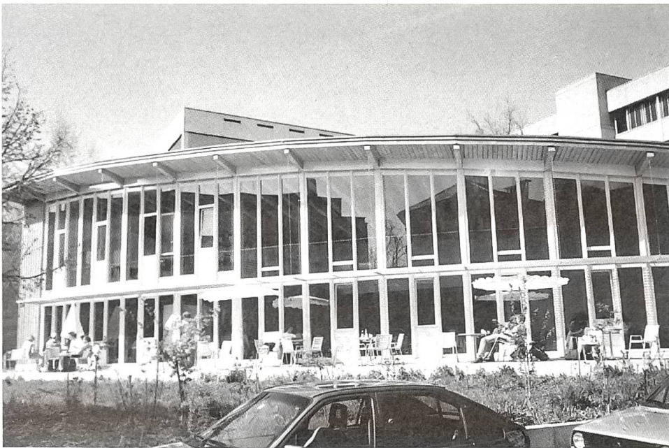
Studentisches Zentrum Bühlplatz der Universität Bern Dieser Holzleimbau wurde an einer europäischen Fachtagung in Dänemark preisgekrönt.
