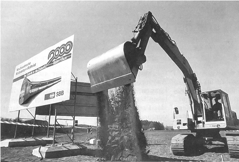
Erste Spatenstiche für Bahn 2000 Bei Hindelbank werden die ersten Erdarbeiten für die Neubaustrecke Mattstetten – Rothrist aufgenommen. (Foto: Hansueli Trachsel, Bern)
