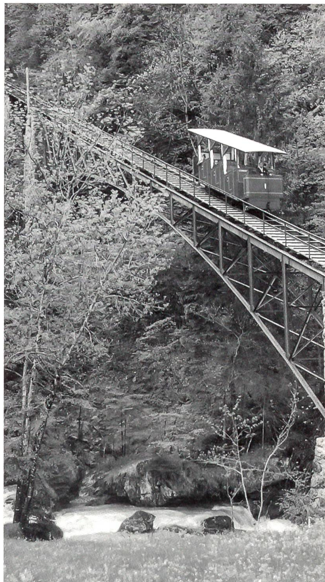
Nach der Sanierung Aufnahme 1999: Einer der roten Wagen auf der grossen Bogenbrücke über dem Reichenbach
