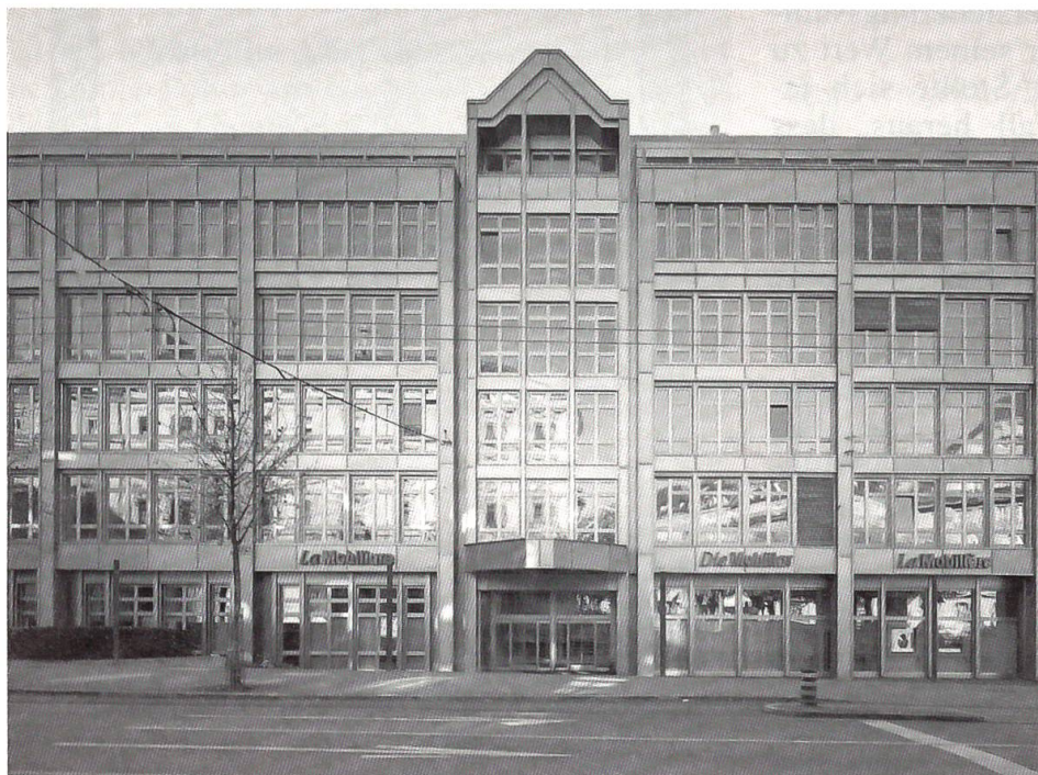
Das heutige Direktionsgebäude der Mobiliar an der Bundesgasse
