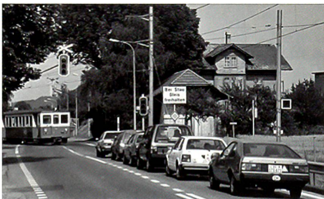
Gefährliche Situation in Schönbühl vor der Sanierung
