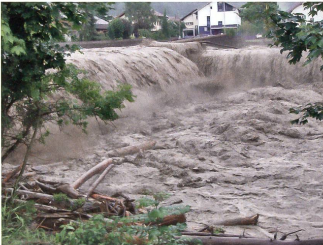
Die 1907–1909 gemauerte Müllerschwelle in Steffisburg beim Hochwasser 2012. (Archiv Autor)
