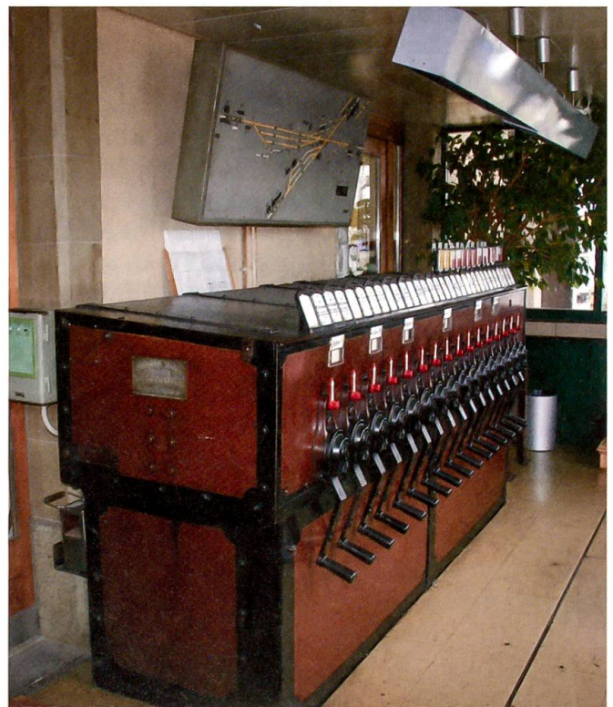
Der mechanische Kommandoapparat, Bauart Bruchsal G
