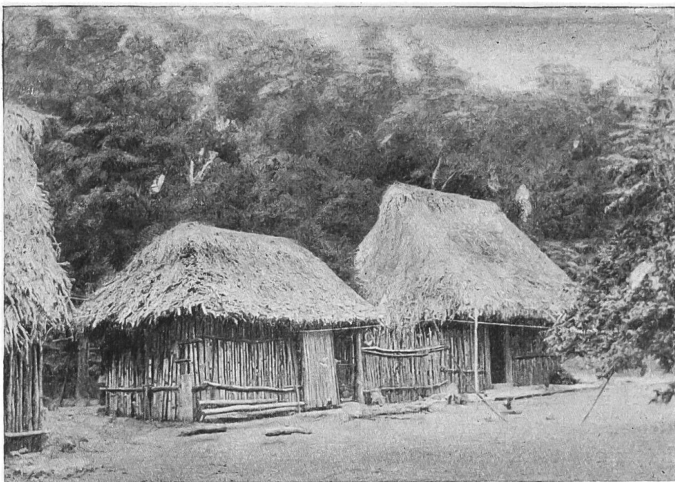
Fig. 3. Bambushütten. Hacienda Santiago de la Peña, südlich Tuxpam. Photographie W. Gugelmann.
