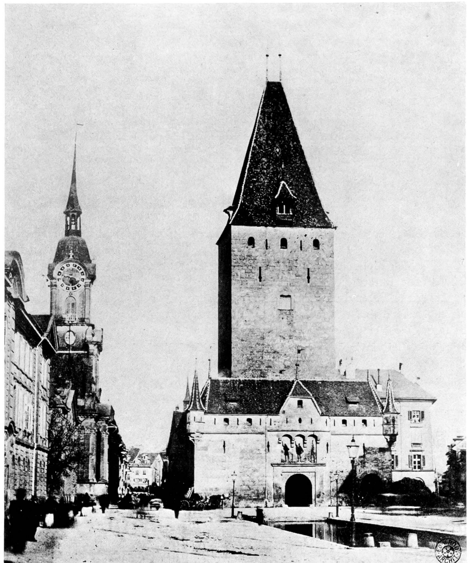
Abb. 13. Der Christoffelturm in Bern: Ansicht von Westen, Photographie um 1864 (Historisches Museum Bern)
