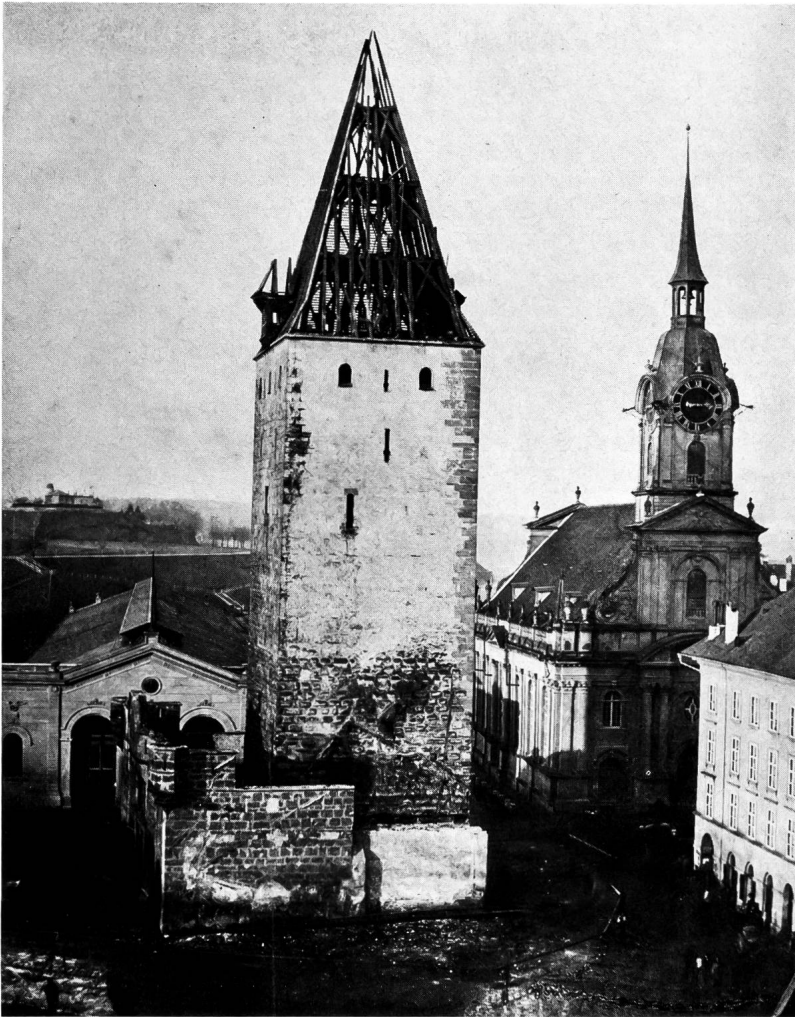
Abb. 50. Der Abbruch des Christoffelturms im Januar 1865. Photographie (Historisches Museum Bern)
