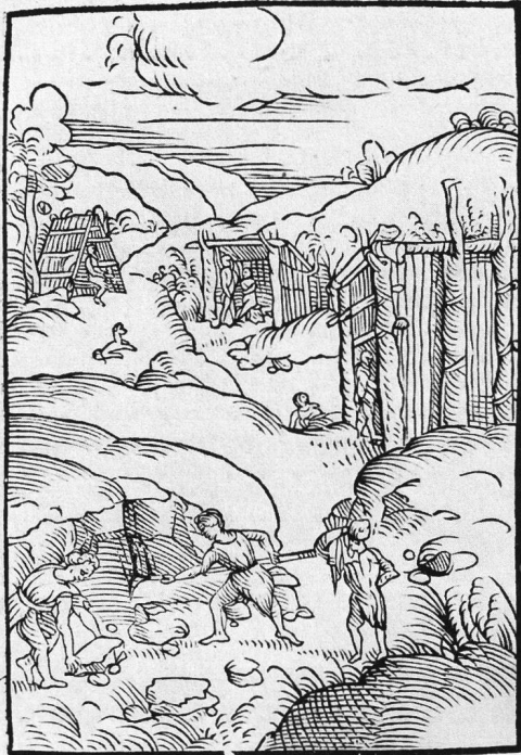
Abb. 1. Bau von Höhlen und Hütten in der Urzeit. Holzchnitt aus der Strassburger Vitruvusaufgabe des Walther Rivius, 1543.
