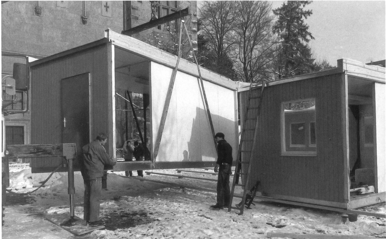
Montage der neuen Bürobaracke südlich des Ostflügels, November 1988
