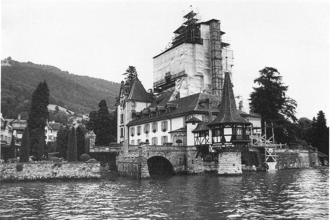
Schloss Oberhofen zu Beginn der Turmrenovation: Seeterrasse mit Landungsstelle für den Baubetrieb und Turm mit allseitigem Baugerüst
