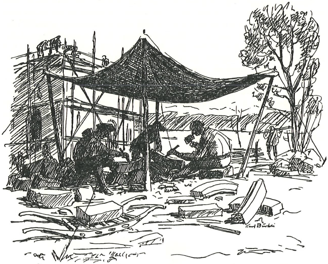
Neubau der Meilener Kirche 1493 - 1495.
