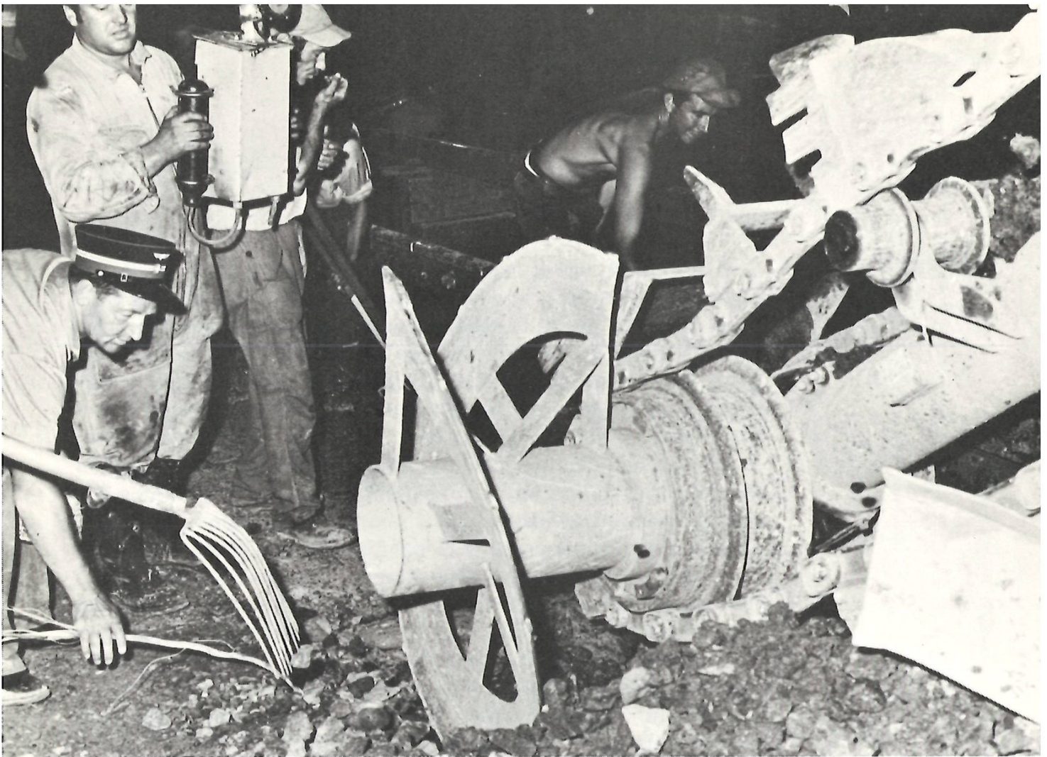
Erneuerung des Schotterbettes auf der SBB-Strecke Meilen–Uetikon, Aug. 1970
