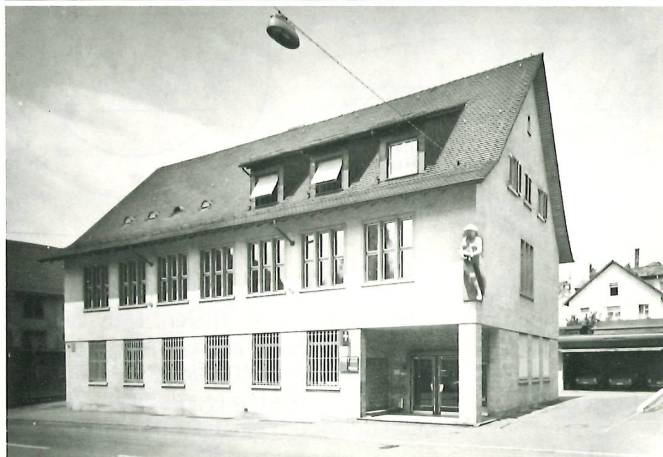
Postgebäude mit Telefonzentrale an der Dorf- strasse, seit 1955.
