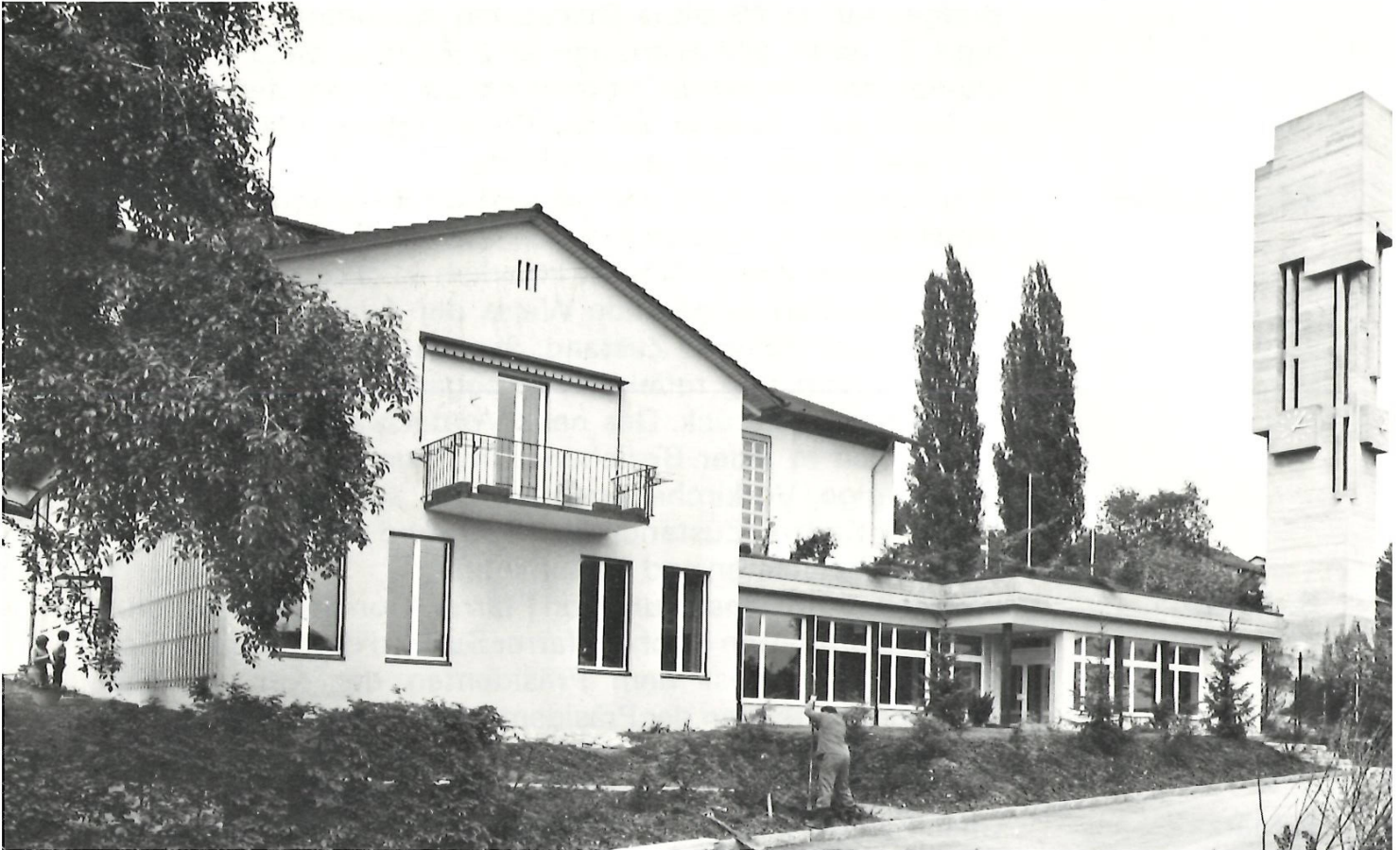
Die katholische Kirchgemeinde hat das Pfarrhaus (links) umbauen und einen Pfarreisaal (Bildmitte) errichten lassen. Einweihung am 20. und 21. Mai 1978.
