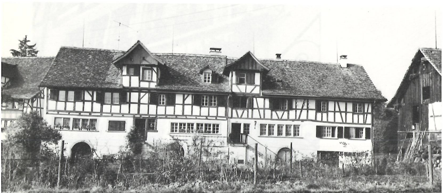
Das alte Reihenhaus nach der letzten Restaurierung im Jahre 1979.
