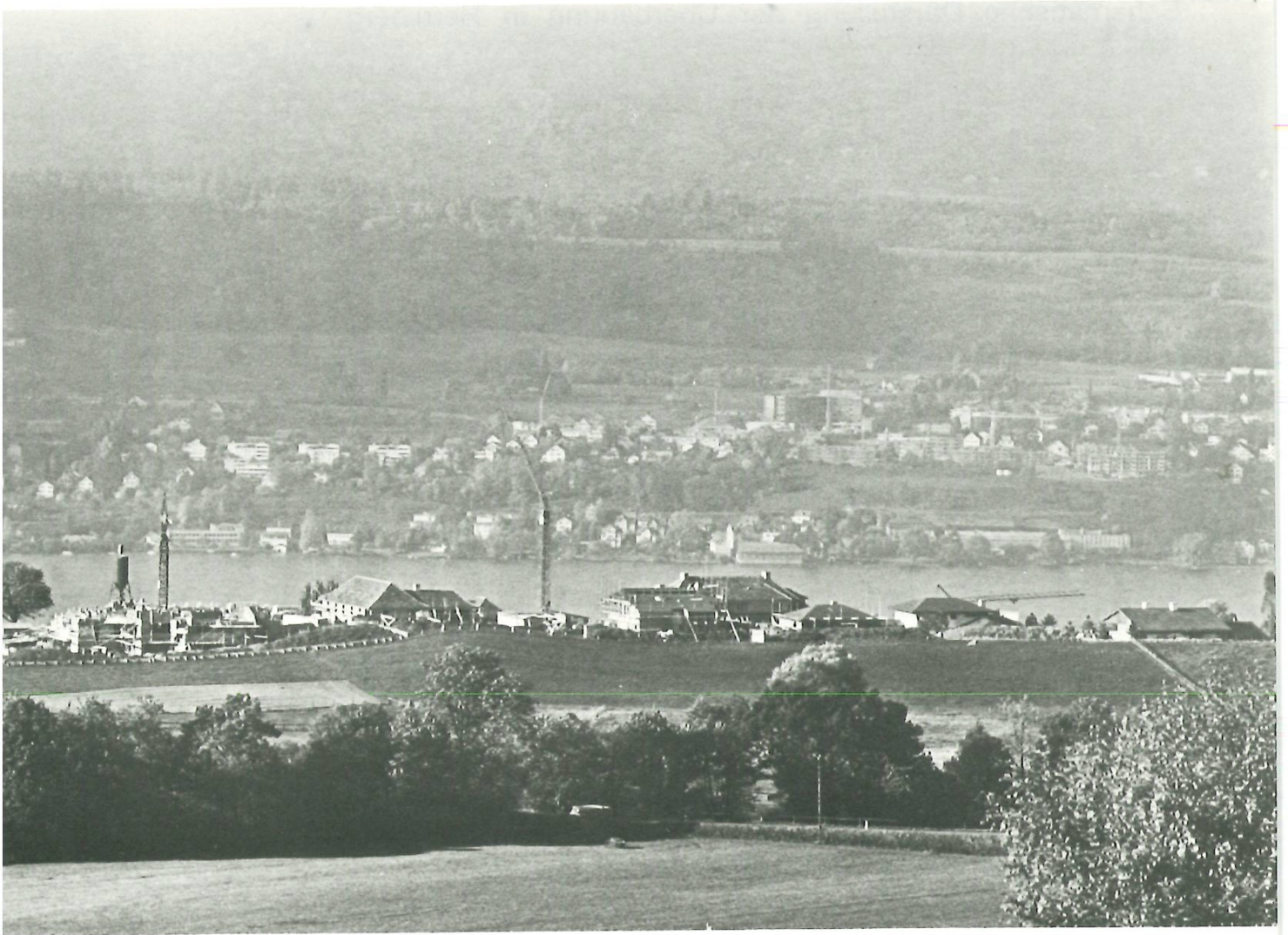
Überbauung zwischen Biswind und der Aussichtsstrasse in Herrliberg. Die freie Sicht auf den See wird verstellt.
