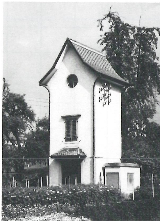
Transformatorhäuschen am Berg, am Herrenweg.
