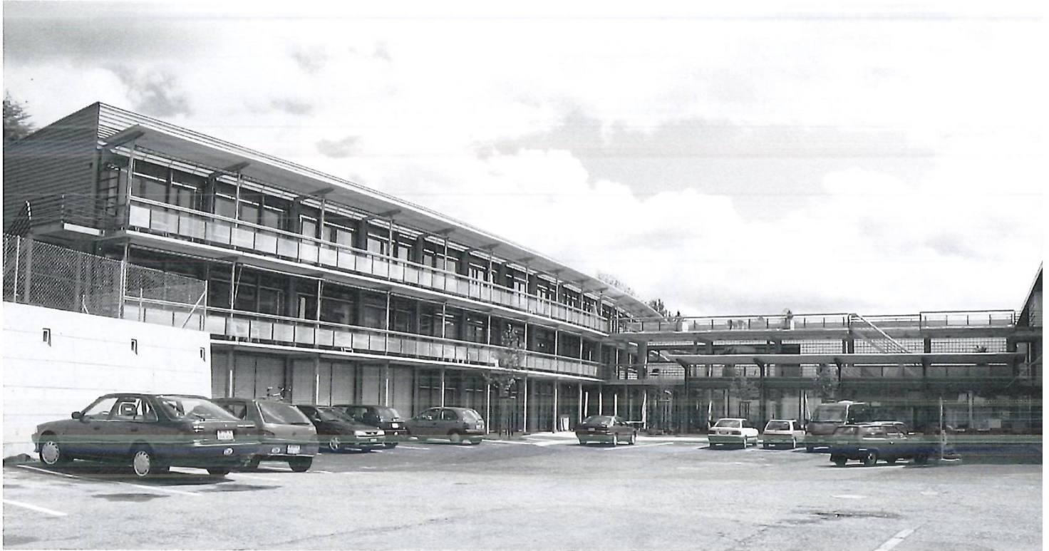
△ Die Südfassade des Pflegeheim-Neubaus auf der «Platten» mit dem Verbindungsgang zum Altbau.
