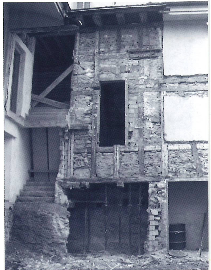
Freigelegtes Fachwerk gegen Norden.
