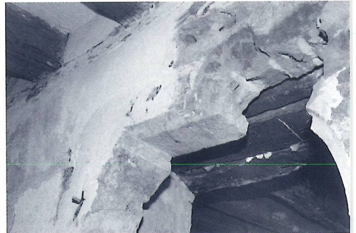
Sturz der freigelegten gotischen Schulterbogentür im Erdgeschoss.
