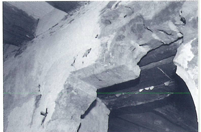
Sturz der freigelegten gotischen Schulterbogentür im Erdgeschoss.
