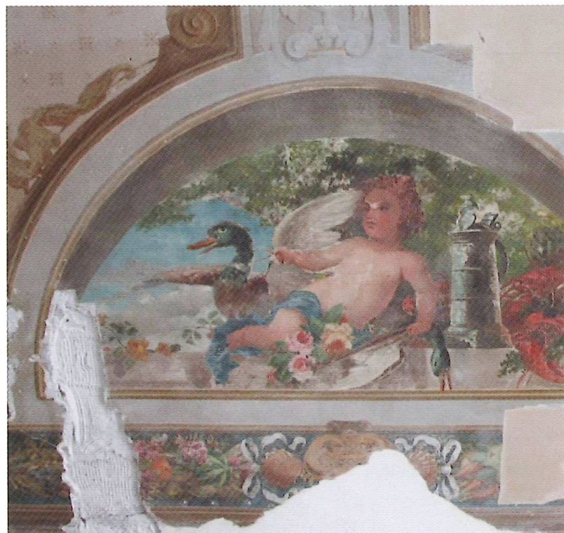
Oben: Decke Gaststube Erdgeschoss. Unten: Deckenlunette im Saal vor Renovation.
