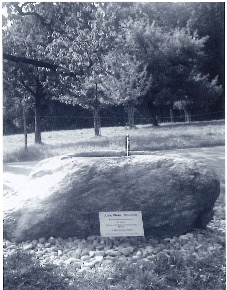
Der 2002 errichtete Trinkwasserbrunnen auf der Burg sichert zugleich den Durchfluss des Wassers in einer «Sackleitung».
