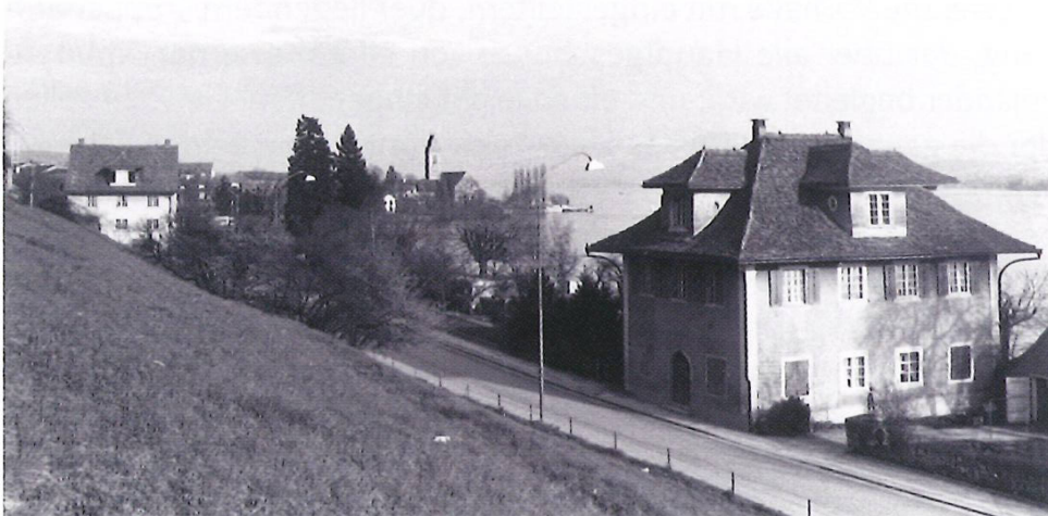
Seehalde und Pächterhaus (Zustand 1975).
