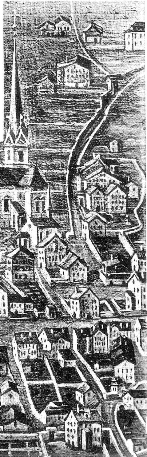
Der Kirchen- u. Spitalplatz von Altdorf. Nach einem Gemälde von Karl Alois Triner 1785.
