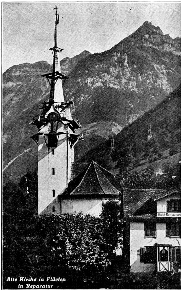
Die alte Kirche von Flüelen in Reparatur Aufgenommen von Phot. W. Schwanden im September 1928.
